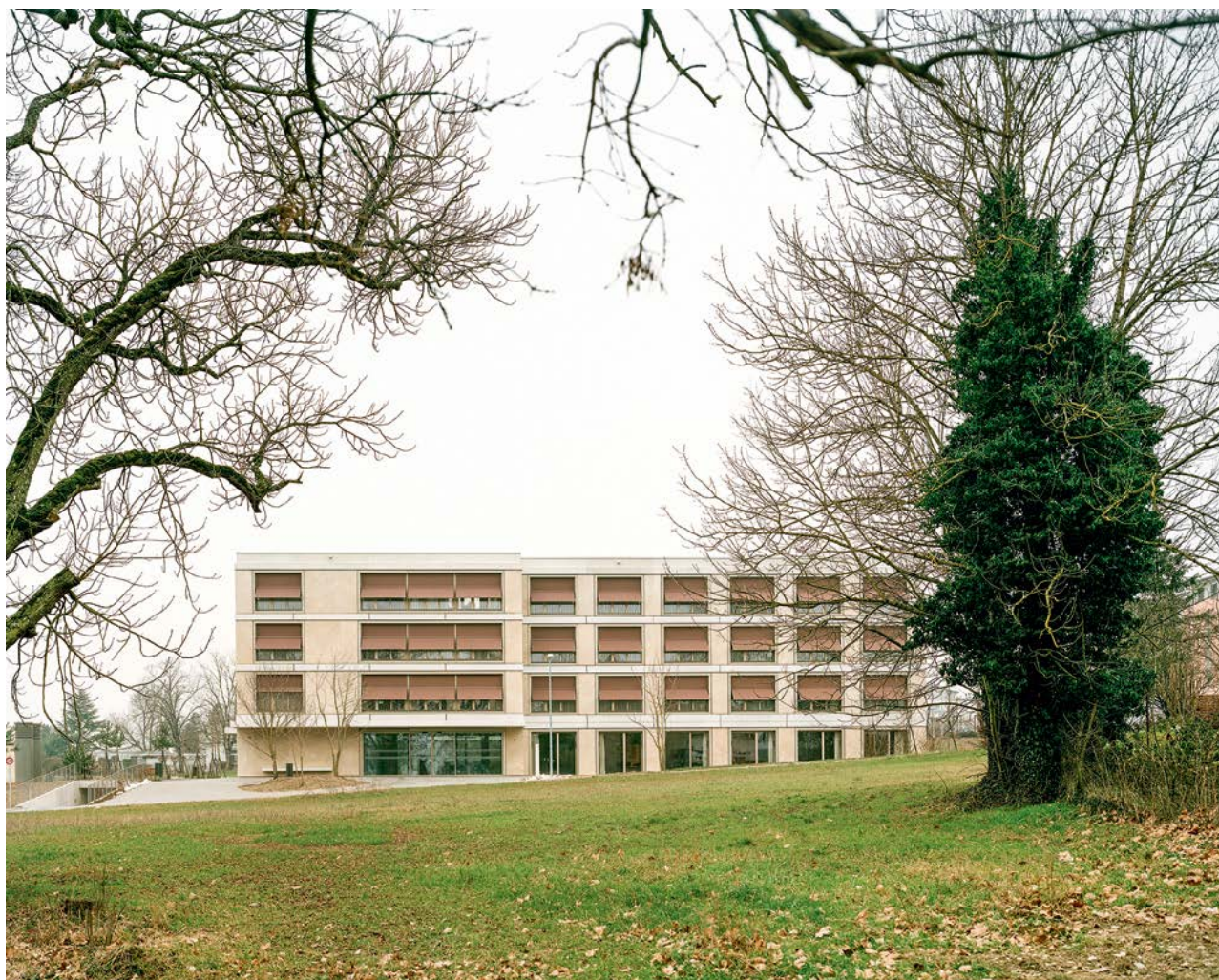
Implanté au centre de sa parcelle, le bâtiment rayonne sur le quartier et la campagne environnante.
