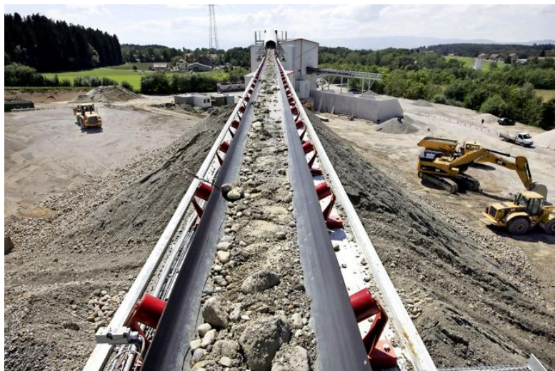
Les matériaux sont triés et concassés. Le recyclage permet d'économiser des ressources comme le sable et le gravier. CHRIS BLASER
